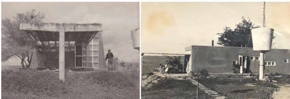
**14, 15.** La pérgola ya con alguna cobertura vegetal. La plataforma todavía sin sus muros de contención que se extienden en bancos perimetrales. El tanque de agua, más tarde ampliado, sobre el poste premoldeado. Los huecos para las ventanas en el muro de albañilería portante también tienen marco y estructura de “ventanitas” premoldeadas.
