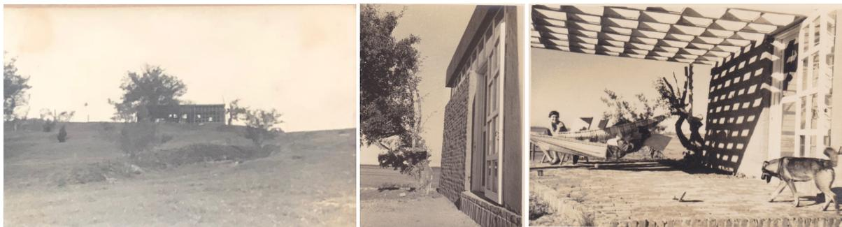
**11.** El bloque principal en obra. Se distingue en la pared posterior una ventana baja para el comedor que desaparecerá durante el mismo proceso de construcción. Por delante la bajada natural en la que se construiría la piscina. **12.** La puerta de entrada a principios de 1956. El arbusto que debía cubrir la orientación norte se apoyaría más adelante en la pérgola. **13.** La pérgola en su estado inicial.
